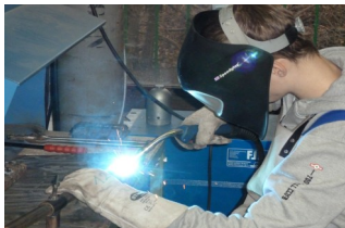
Verbinden der Bauteile durch MAG-Schweißen
